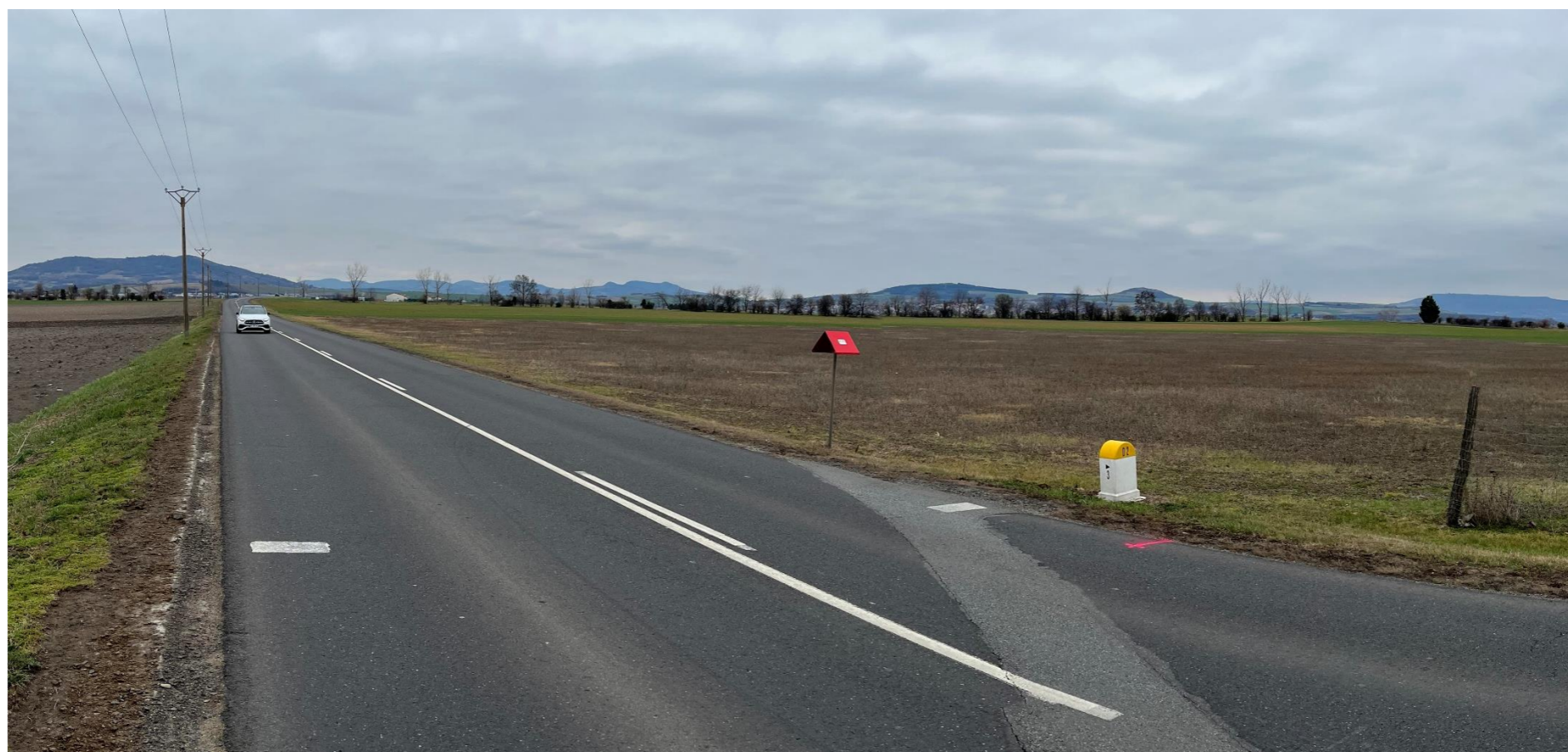
Figure 12 – Vue Nord – site de projet à l'état initial
